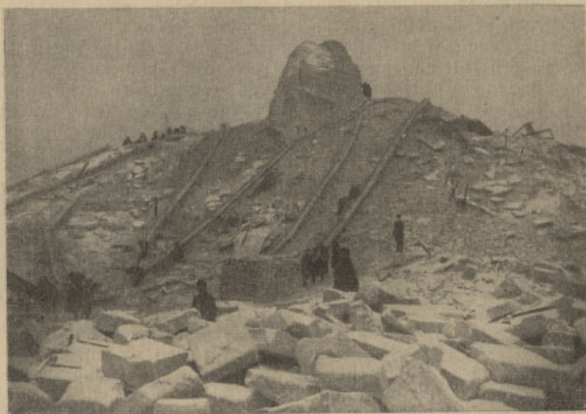
Der Trümmerhaufen der Uspenski-Kathedrale in Moskau, die im Winter 1931/32 abgebrochen wurde.
