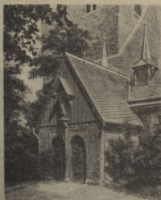
Arch. Oswald von Geyers
