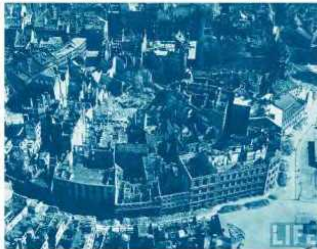
Разрушенный войной Мюнхен
